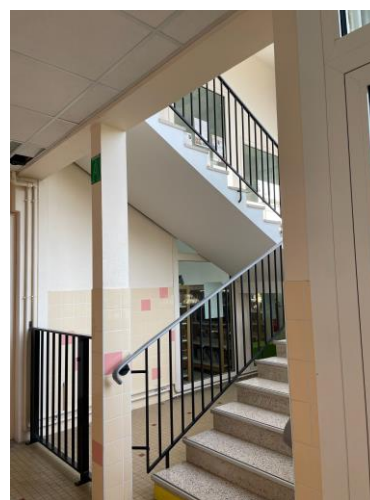
Cage d'escalier de desserte de l'établissement vitrée coté C.D.I.
