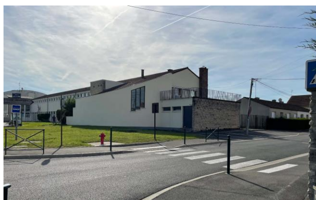
C.D.I. – locaux techniques – angle rue des Tournelles et rue du Clos de la Ferme
