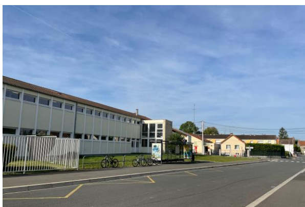
Façade Nord – cage d'escalier et C.D.I. – rue des Tournelles
