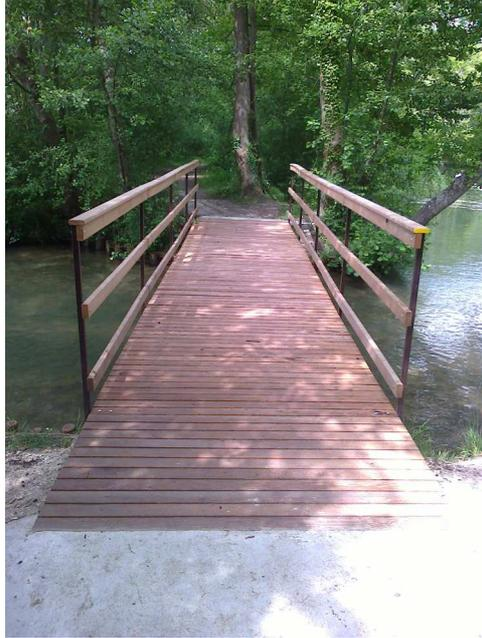
Figure 22 : exemple de passerelle pouvant remplacer les passages busés en berge de Seine
