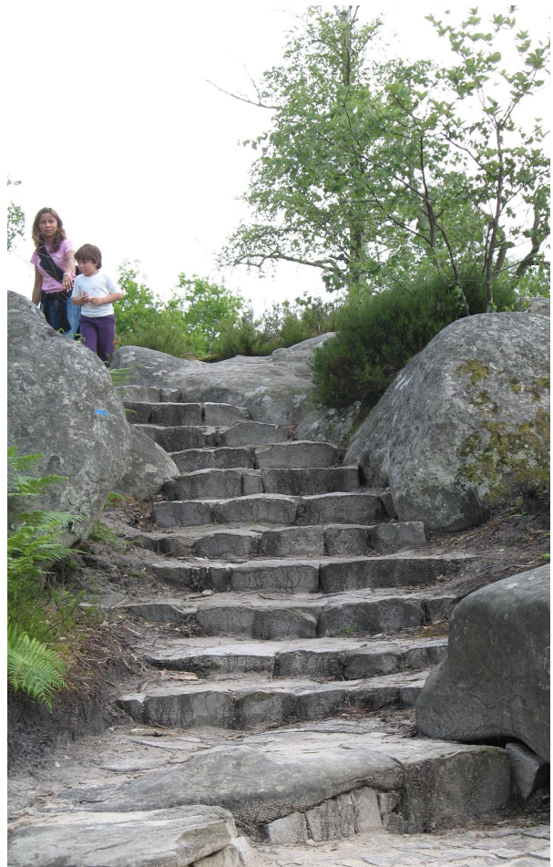
Figure 1: La restauration des sentiers bleus et la lutte contre l'érosion passent également par la réalisation de nouveaux ouvrages, comme cet escalier de grès, à Franchard
